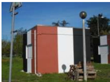
Maisons modèles utilisées pour étudier le confort d'été, - Laboratoire National de Génie Civil (LNEC)- Lisbonne
